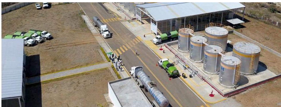
Figura 6. Vista Aérea de una nave industrial en el PIMO “Oaxaca 2000”
