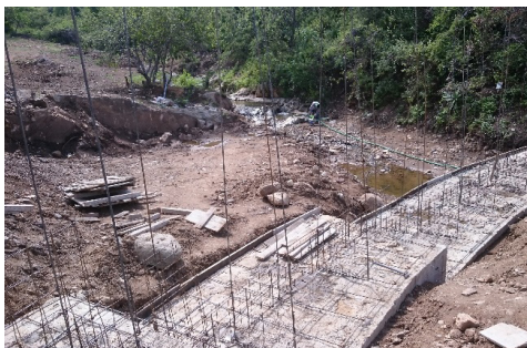
Figura 11. Vista de la cimentación de concreto hidráulico reforzado y de donde salen los anclajes para la estructura de la pantalla de ferrocemento.
