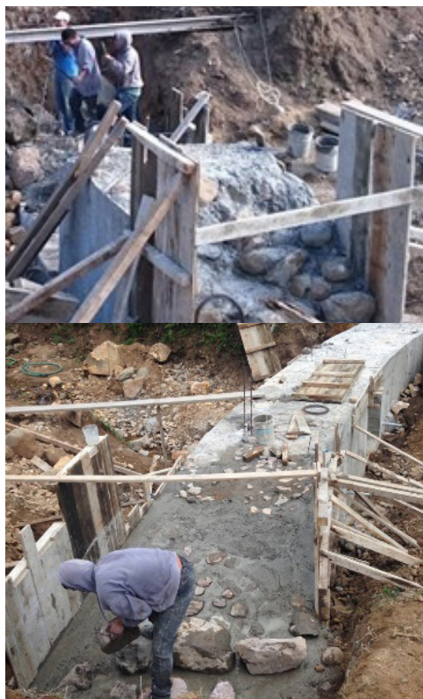
Figuras 9 y 10. Detalle de la construcción del soporte de la cimentación de una pantalla de ferrocemento.
