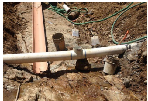
Figura 8. Limpieza de la roca de apoyo
