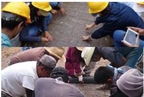
Figuras 12 y 13. Detalle del tejido de mallas de acero.
