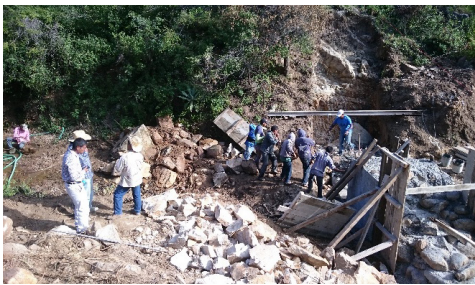
Figura 7. Materiales regionales para la construcción de la cimentación de micropresas de ferrocemento.
